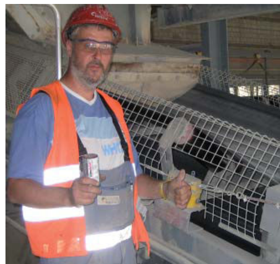
Ueli Schneider, montando los engrasadores en la planta de Holcim de Birsfelden, se muestra muy satisfecho con las prestaciones de BESLUX LUBE .
