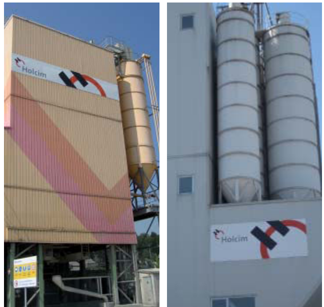
Holcim Kies und Beton AG en Glattbrugg y Birsfelden, Suiza
