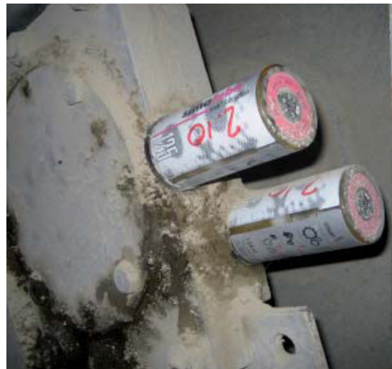
Dos BESLUX LUBE engrasan los contracojinetes de un árbol de accionamiento.
